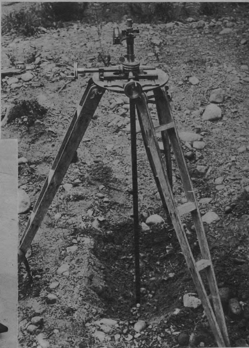
O i k . Nummelan perusviivan päätepisteet on kätkelty maan sisään ja kiinnitetty vahvaan sementtialustaan. Kuvassa näkyvä valkoinen metallikappale kuopan pohjalla on loinen päätepisteistä ja kuopan päälle on asetettu luotauskoje.
